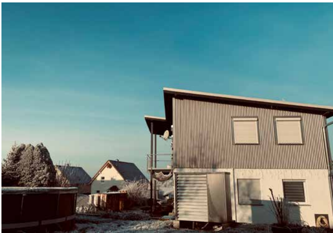
Auch an diesem Beispiel, einem Fachwerkhaus mit angrenzender Scheune (BJ 1900) in Schöffengrund Schwalbach, sieht man die Wirtschaftlichkeit der AERO ALM 6-15 Luftwärmepumpe.
