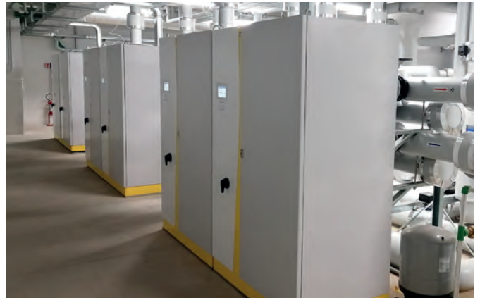
Auch bei der Auswahl des Heizsystems im Green Retail Park in Torino setzt man auf die Expertise von iDM. Die Gesamtfläche von 15.000 m 2 erstreckt sich auf 5 Ebenen und wird mit einer Kaskadenanlage - 6x Terra SW Max 140 kW - beheizt.
