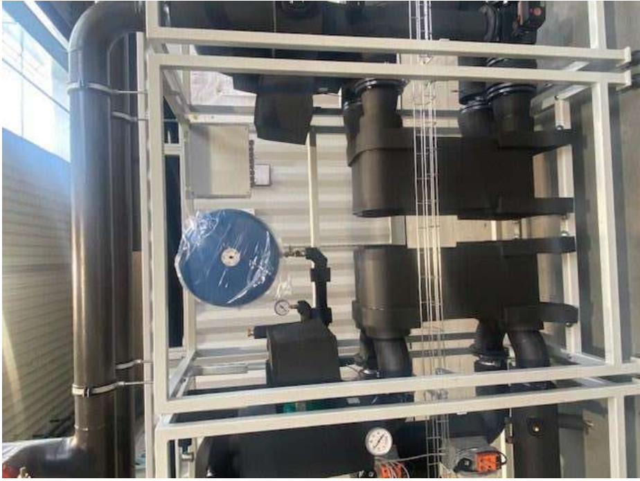
Vorgefertigte und gedämmte Modulbaugruppe.
