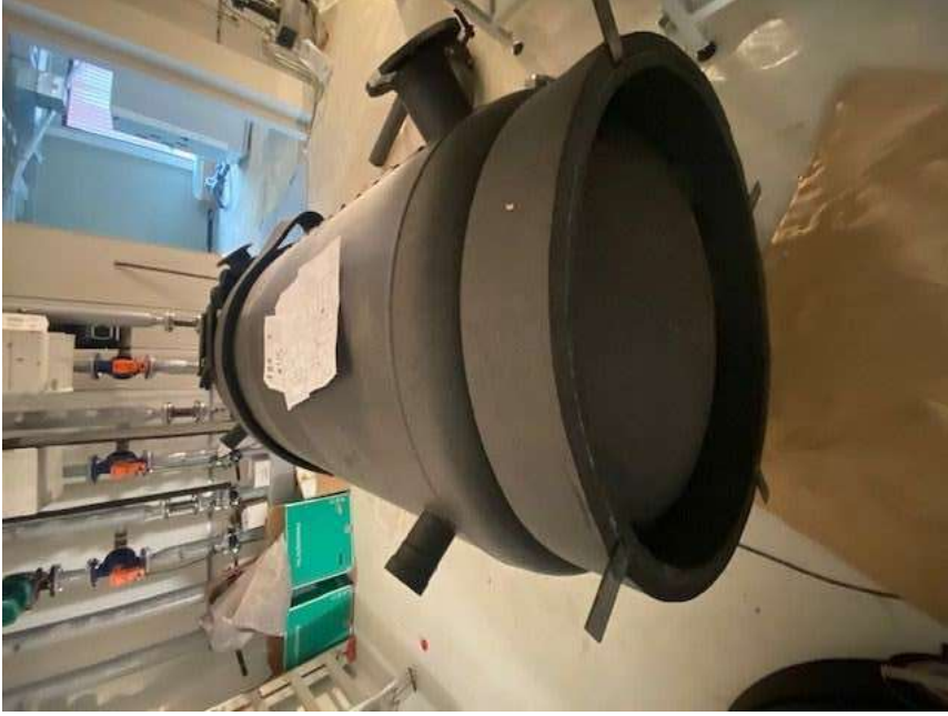
Dämmen der IDM-Kühlreisepuffer.
