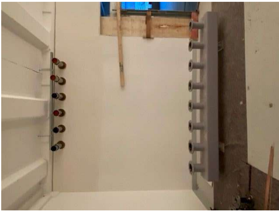
Vorgefertigter Kühlkreisverteiler.
