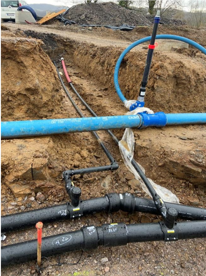
Hauptanbindeleitung Verlegung in der Strasse, Abgang Hausanschluss
