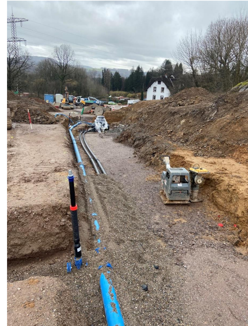
Verlegung der Ringleitung
