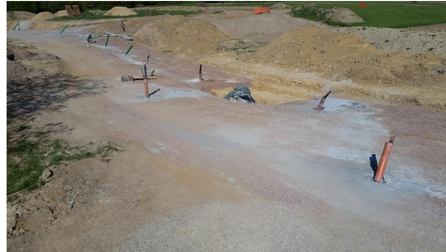
EWS-Bohrung im Umfeld einer TW-Leitung
