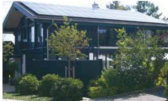
Innen Wärmepumpe, am Dach Photovoltaik
