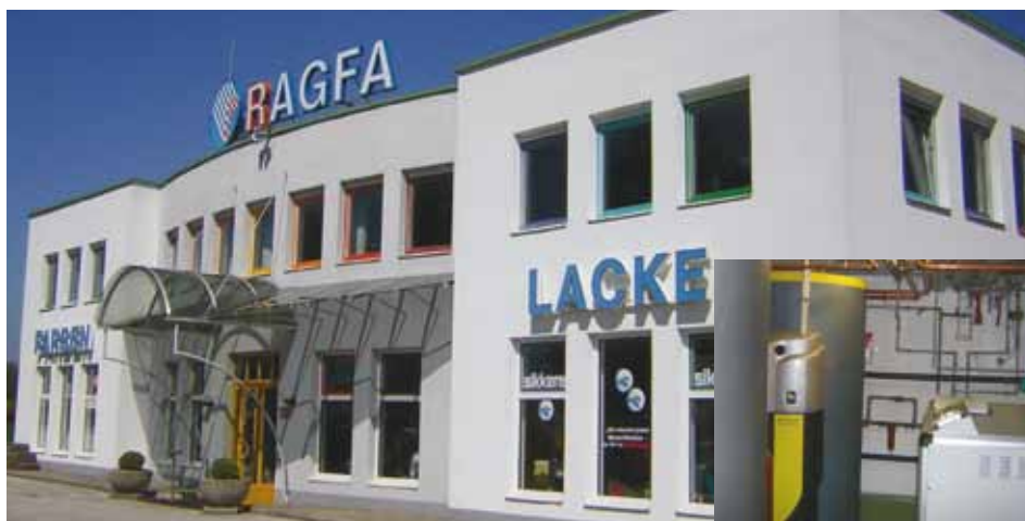
1.300 m 2 heizen und kühlen für Büro und Verkaufsraum in Klagenfurt. im Kleinen Bild die TERRA MAX mit Hygienik Pufferspeicher und Frischwassertechnik
