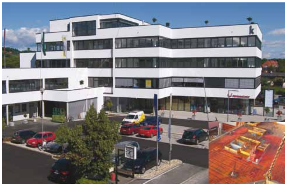
Das Kundenzentrum der Firma Kindermann in Leibnitz mit Betonkernaktivierung (kl. Bild)
