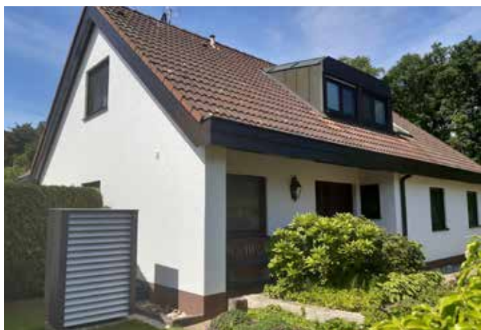
Im Einfamilienhaus in Roßtal (DE) kommt in Zukunft eine AERO SLM 6-17 Luftwärmepumpe zum Einsatz.
