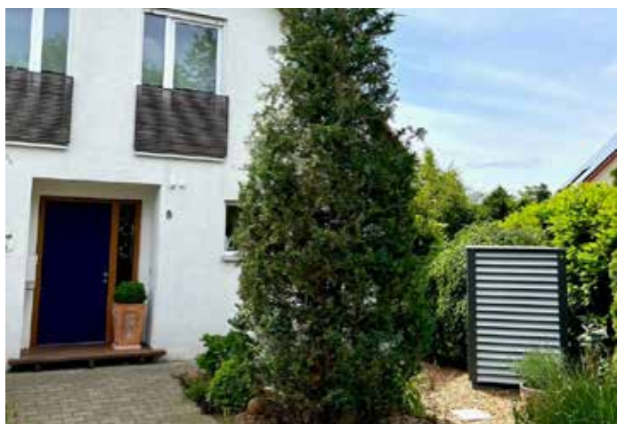
Das Einfamilienhaus in Hagenbüchach (DE) wird seit der Sanierung mit einer AERO SLM 6 -17 Luftwärmepumpe von iDM beheizt.
